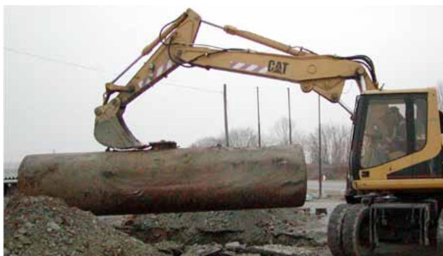
Rimozione di un serbatoio interrato
